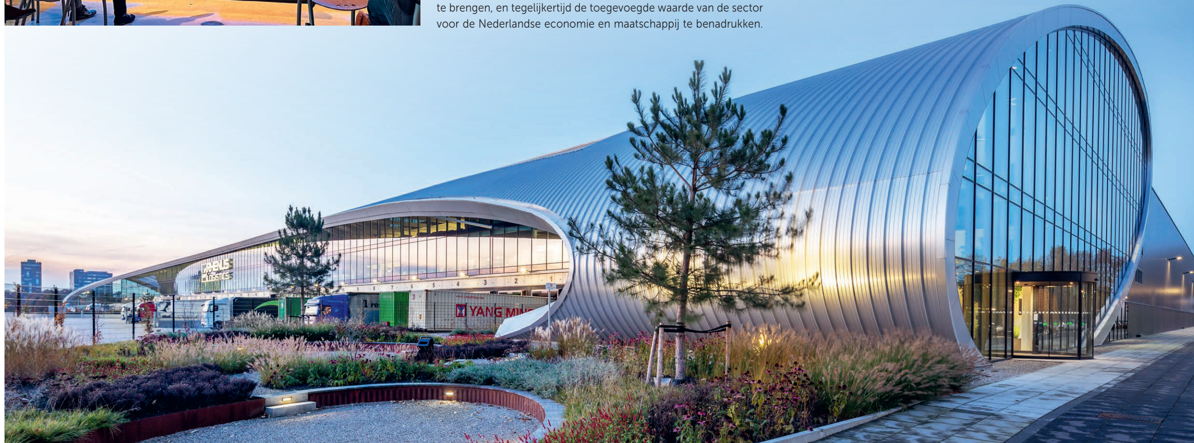
Rhenus Warehousing Solutions te Tilburg, ontwikkeling Dokvast, ontwerp en uitvoering Heembouw
