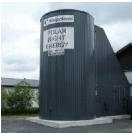
Figuur 3: zandbatterij tijdens de test
